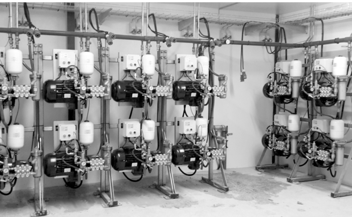
Stationære Economic opsat på dansk industrivirksomhed til afvaskning af lastbiler.
